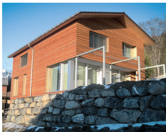
Konstruktion und Fassade aus Bergmondholz.
