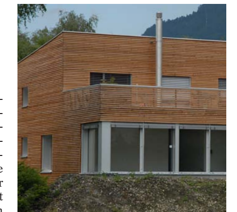
Das Bergmondholz dieser Gebäudefassade in Plattis stammt aus dem Bergwald der Ortsgemeinde Wartau.
