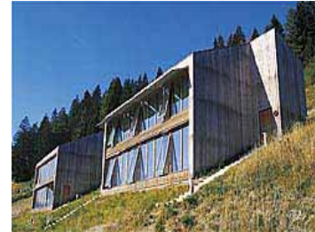
Abbildung 1: Das Direktgewinnhaus in Trin/CH steht auf 900 m.ü.M. und kommt ganz ohne Heizung und Lüftungsanlage aus.
