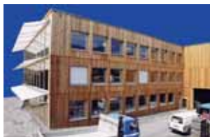
Abbildung 3: In diesem Bürogebäude in Chur/CH arbeiten rund 30 Mitarbeiter, die noch nie im Kalten gegessen haben, obwohl es keine konventionelle Heizung gibt.
